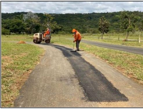
Figura 11. Recuperação de trechos do asfalto da coopervia.
