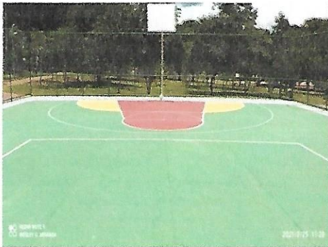
Figura 3. Recuperação da quadra Poliesportiva interna.
