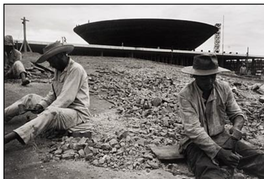
Foto 3.60: Operários (Candangos) trabalhando na construção de Brasília.
