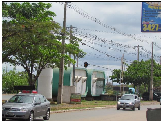
Foto 3.68: Posto policial desativado às margens da DF- 001.
