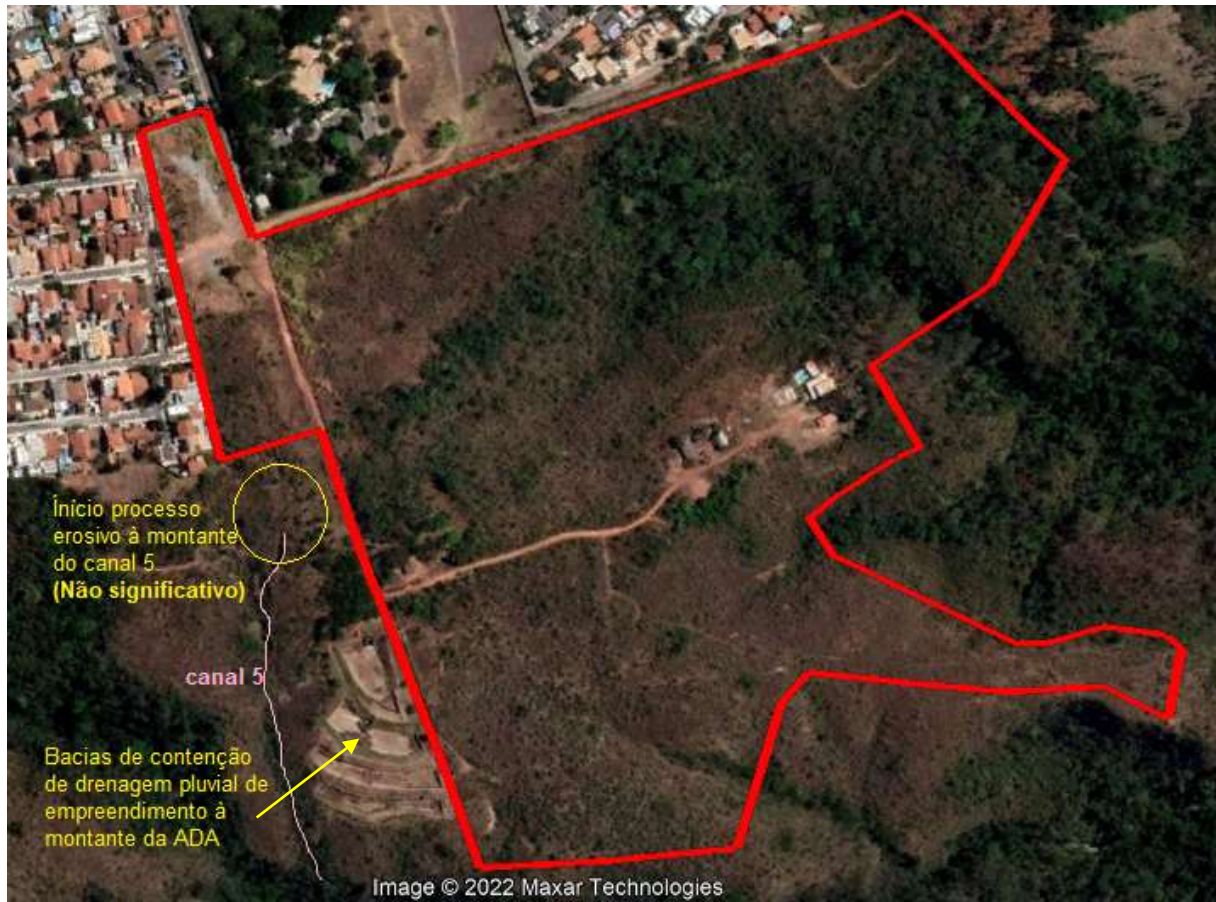
Figura 41 – Identificação de um trecho inicial de processo erosivo, porém não demanda intervenção prévia, tão pouco, ações de recuperação específicas.
