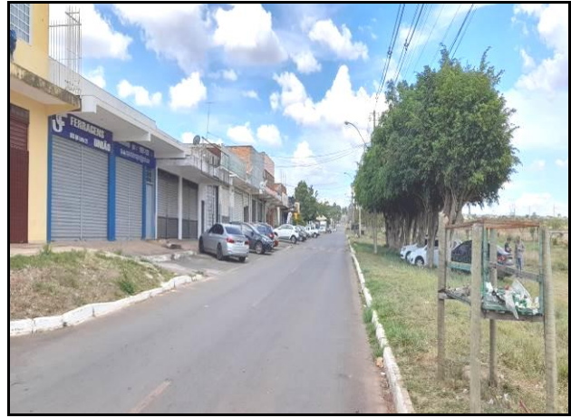
Foto 25. Energia elétrica presente no SEE.
