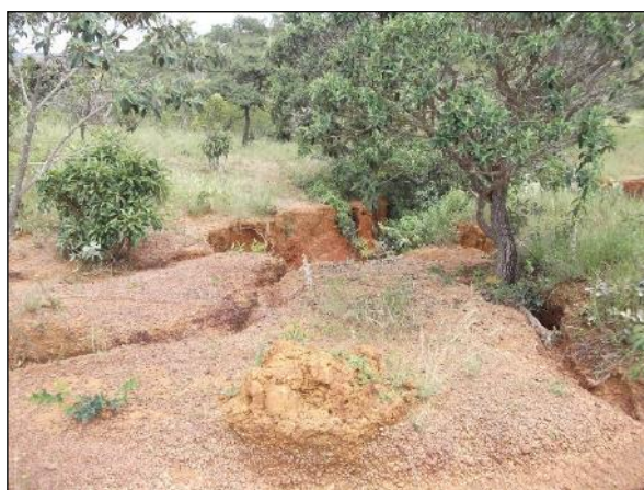
Foto 3.26: Forte erosão provocada por deficiente drenagem superficial (UTM 204.460/8.248.575).
