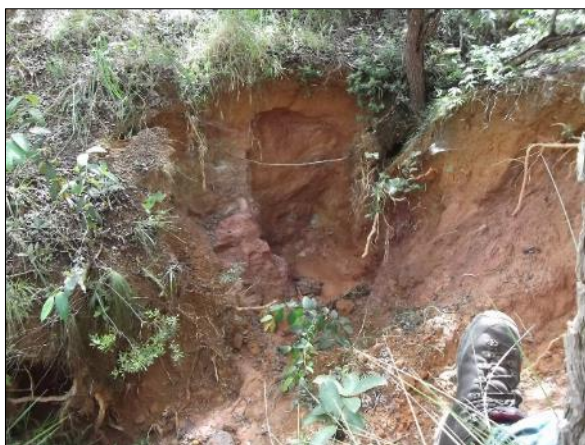
Foto 3.29: Local de erosão em drenagem seca. Sem indícios de cavidades (UTM 204.934,00/8.248.604,00).
